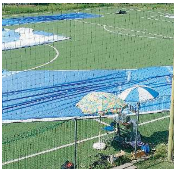
La prova. La copertura è realizzata unendo più teli
